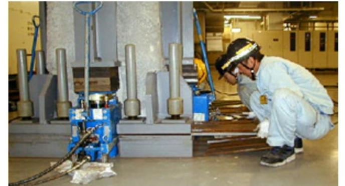
沈んだ部分だけ柱を持ち上げ鉄板を挟むなどして調整します。
