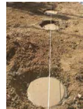
仕上がり状況
