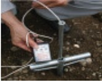
水位測定 地下水位を調べます。
