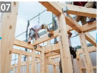
07 金物による柱と梁の施工
