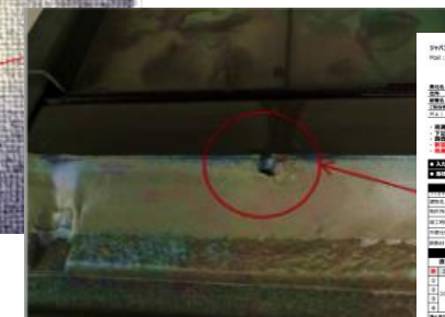
サッシ上部破断
